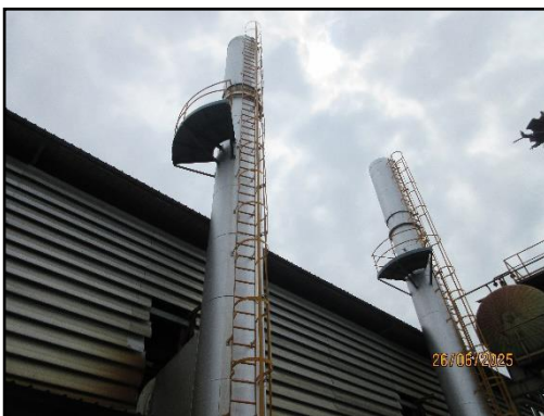
รูปที่ 2-1 ปล่องระบายอากาศของหม้อน้ำ ขนาด 20 ตัน
