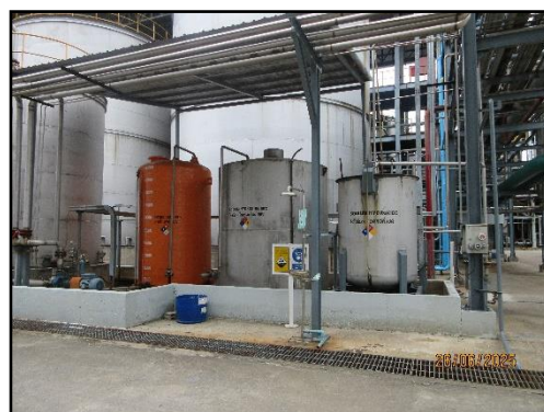
รูปที่ 2-51 ถังเก็บ NaOH
