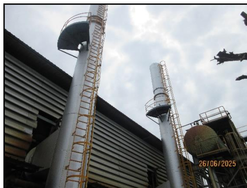
รูปที่ 2-1 ปล่องระบายอากาศของหม้อน้ำ ขนาด 20 ตัน
