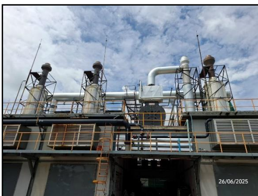
รูปที่ 2-2 ปล่องเครื่องกำเนิดไฟฟ้า (Gas Engine Generator)
