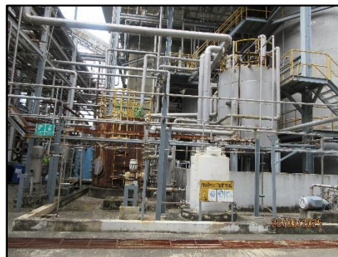
รูปที่ 2-53 ระบบที่รวบรวมสารเคมีกรณีรั่วไหล ไม่ให้ปนเปื้อนสู่แหล่งน้ำสาธารณะ
