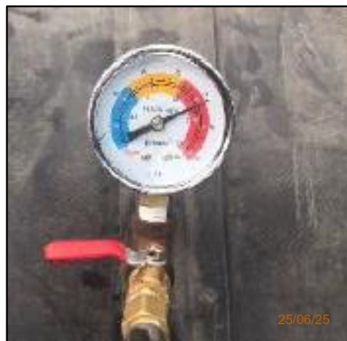
รูปที่ 2-49 การติดตั้งอุปกรณ์เพื่อความปลอดภัยของระบบท่อลำเลียงก๊าซชีวภาพ
